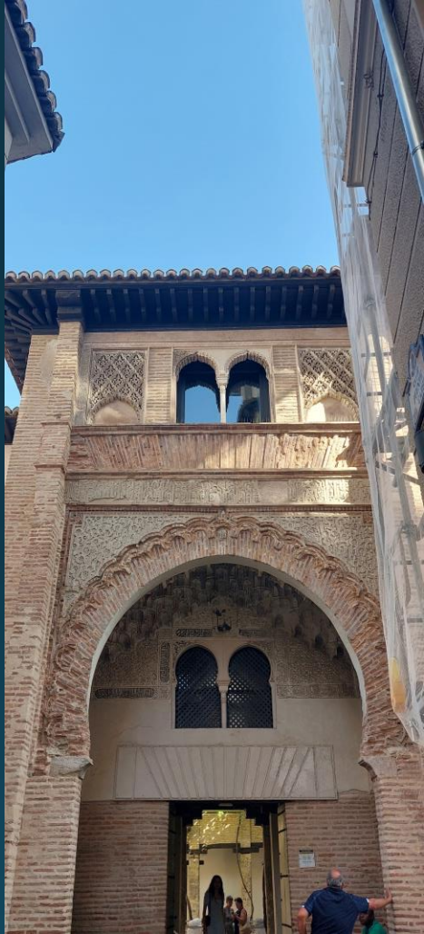
Porte d'entrée du Corral
